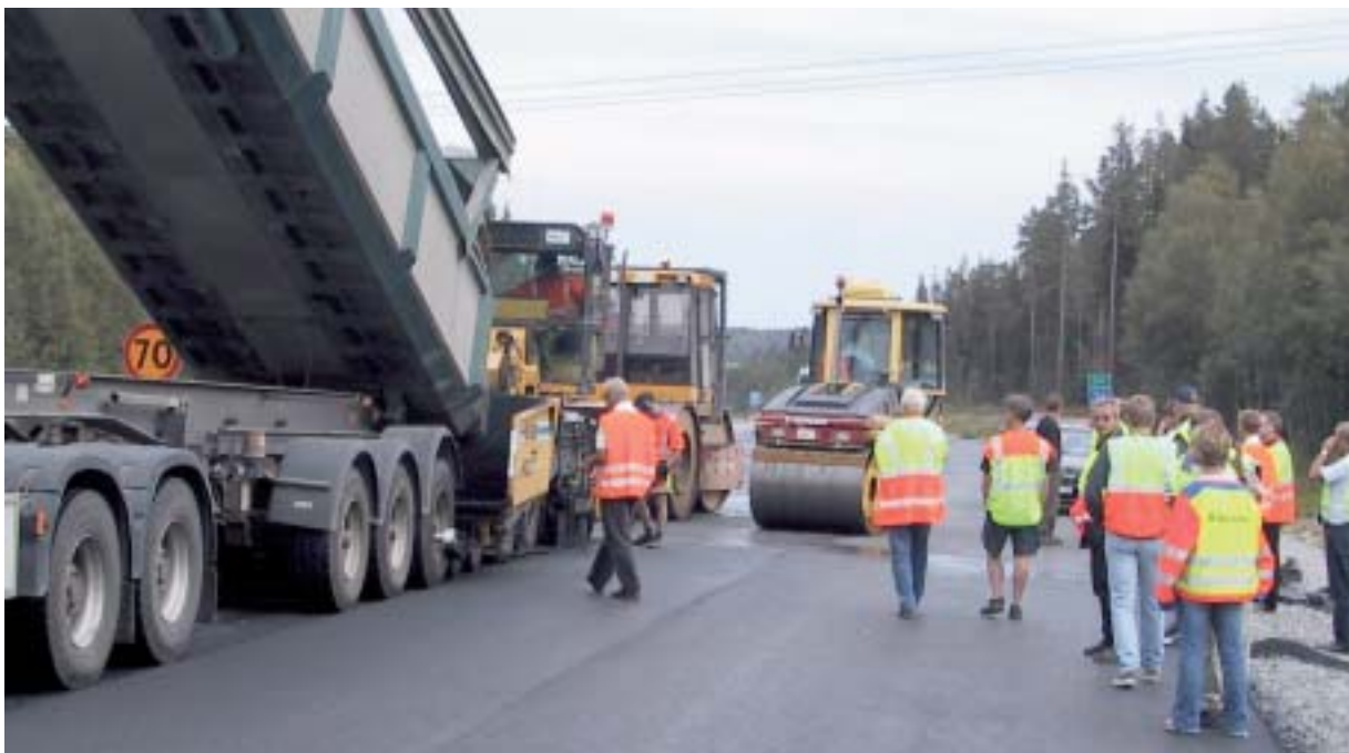
Tack vare den lägre tillverknings temperaturen med WAM förlängs beläggningens livslängd.
